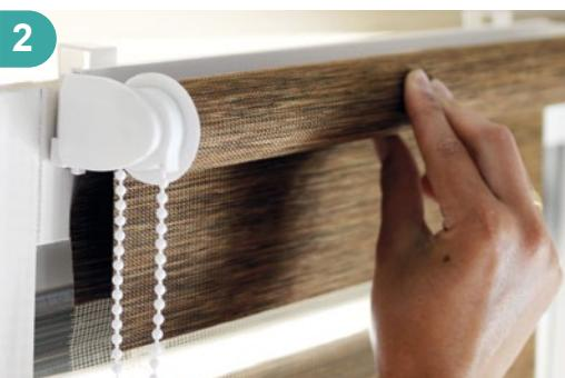
Nalepte penové pásky na háčiky, odstráňte ochrannú fóliu z háčikov. Umiestnite roletu tak, aby zakrývala celú okennú tabuľu a prekrývala zasklievacie lišty, a pripevnite ju na okno.
